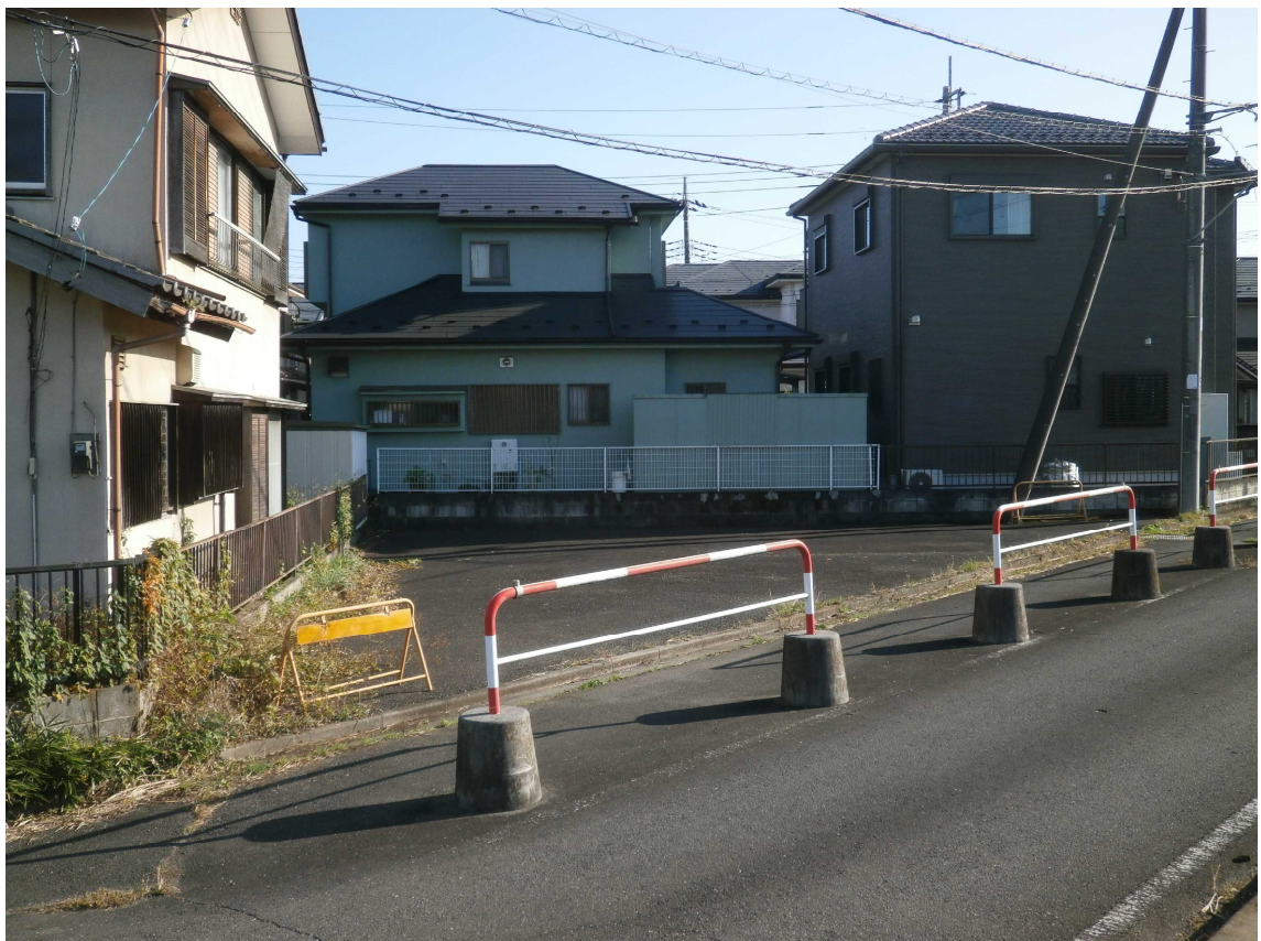
物件02_岩井西陸橋側道02
