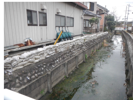
岡本橋から下流側の現状
