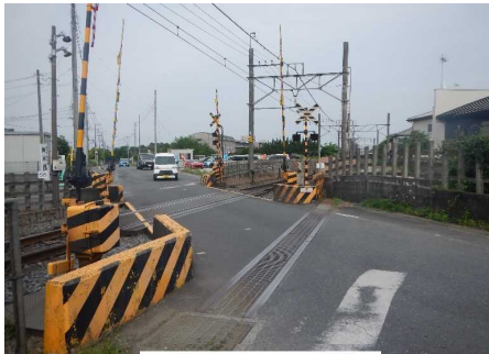
踏切西側の現状
