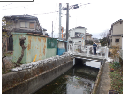
岡本橋から上流側の現状
