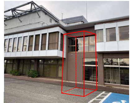
写真1:エレベーター設置予定箇所
