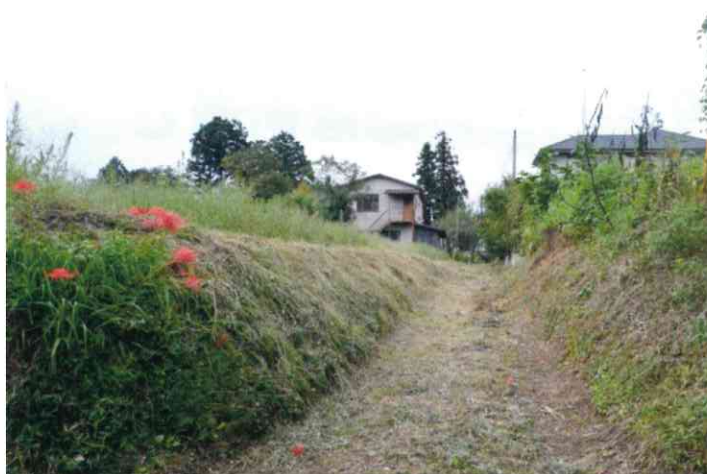
仏坂遺跡掘割遺構の様子
