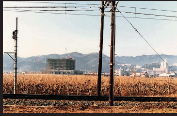
建設中の毛呂山町役場庁舎。昭和54年頃の写真。
