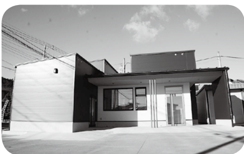
12月に完成した『ゆずの搾汁棟』
