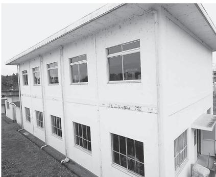
苦林浄水場のポンプ室兼電気室は耐震診断の結果、耐震補強が必要な建物という結果が出ました。休むことなく動き続けている施設のため、耐震化工事は綿密な計算と計画が必要です。現在更新方法を検討しています。
