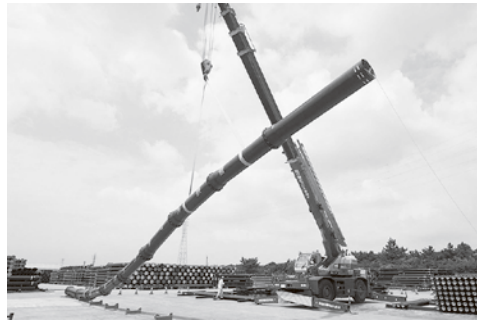
耐震管のダクタイル ちゅうてつ 鉄管NS形
