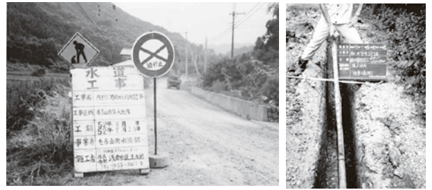
昭和52年当時の水道工事の様子（滝ノ入地区）
