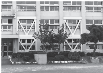
耐震工事を終えた現在の毛呂山小学校
