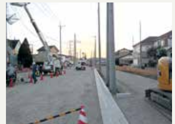
武州長瀬駅北口周辺地区整備事業
