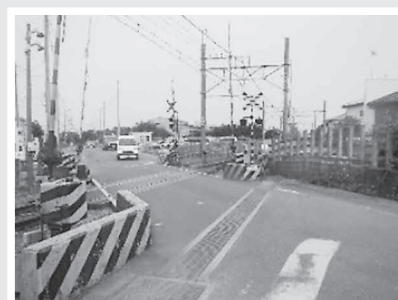
東武越生線第55号踏切道
