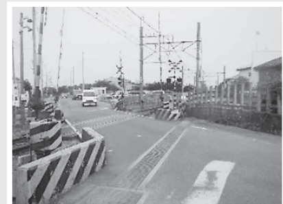
東武越生線第55号踏切道
