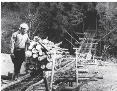
木製のレールに乗せたソリに伐採した樹木を乗せ、人力で運搬しています。昭和50年代の作業の様子です。
