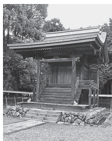
平成22年 修理後の本殿
