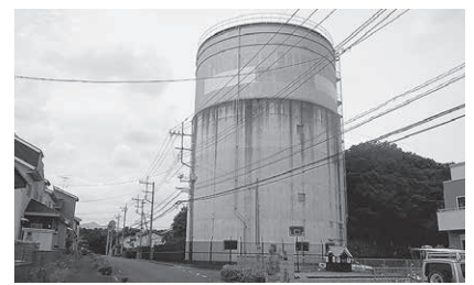
〈目白台配水場〉
