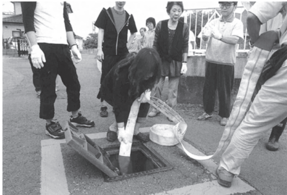
むさし野自治会自主防災組織による消火栓の点検
