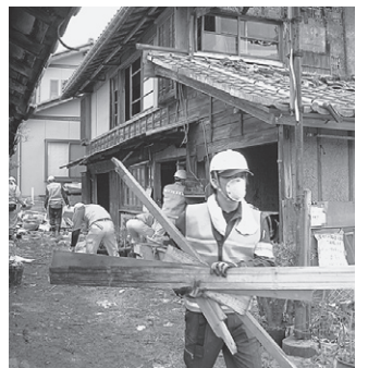
福島県いわき市での瓦礫撤去作業
