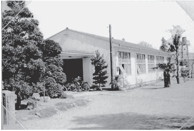
川角小学校旧職員室・教室棟 昭和35年（岸健司さん提供）
