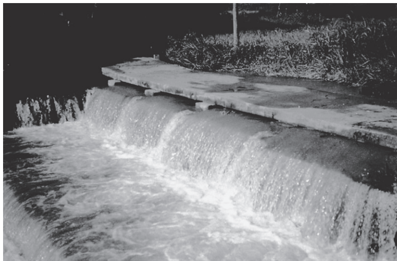
滝ノ入冠水橋 昭和47年9月
