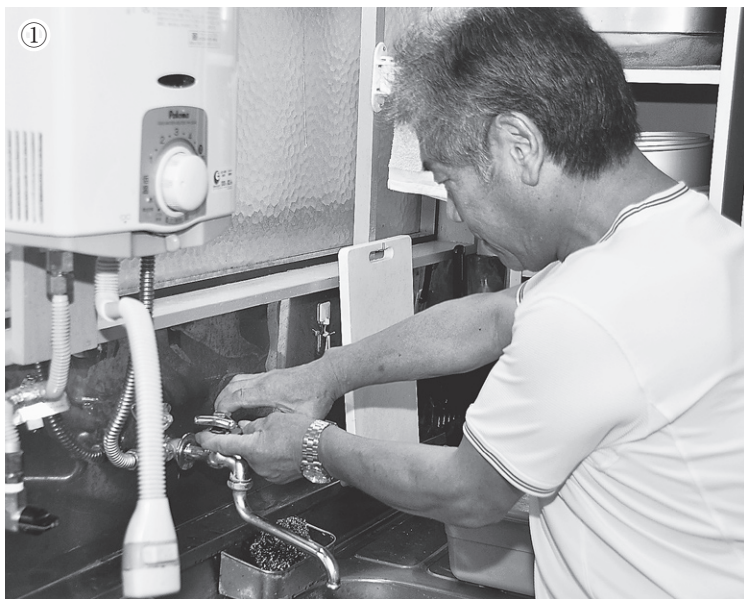
①②/水道のパッキンを交換してくれた藤井さん（68歳）は、15分程で作業を終えた。その後、電気コタツのスイッチが入らないという依頼を受けて電気コードを点検し補修した。この日の作業は1時間以内に終了した。
