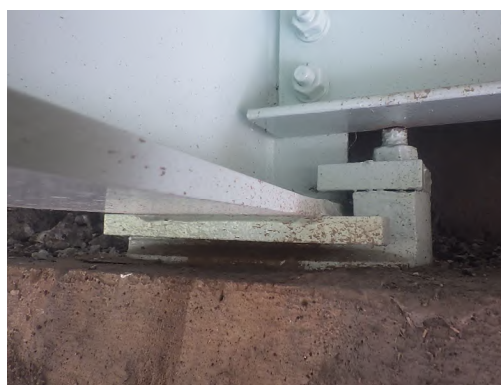
支承【塗替え後】
