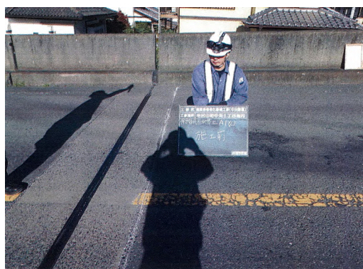
伸縮装置【取替え前】
