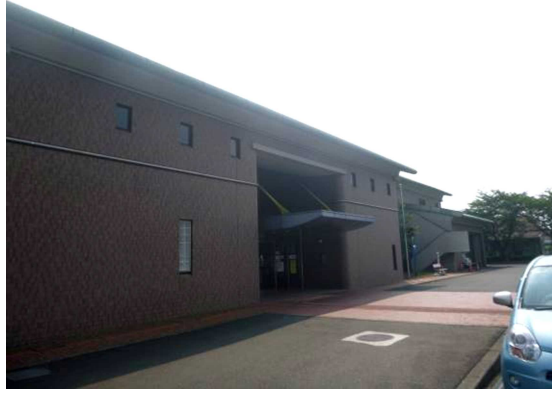
(写真) 本町東部地域に立地する「保健センター」。このような公共公益施設への緑化を推進し、地域における緑化のシンボルとしていきます。
