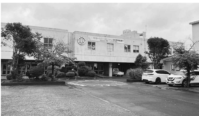
スケジュールが変更となった川角中学校区
