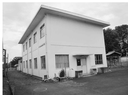
苦林浄水場設備棟、20億円の更新計画〔内、仮設費に6.5億円〕
