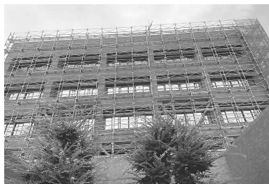
完成が待たれる外壁改修工事
