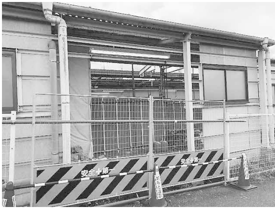
工事が始まった川角駅南側改札口
