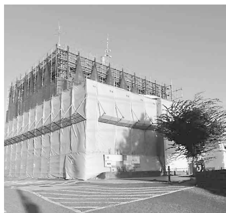
工事が難航している庁舎外壁工事
