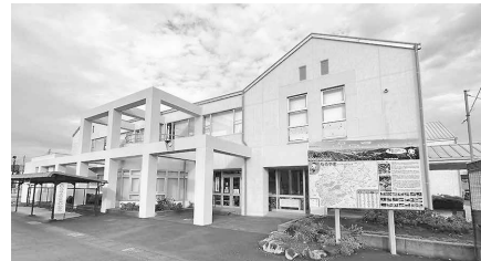
きれいに改修工事がなされた中央公民館
