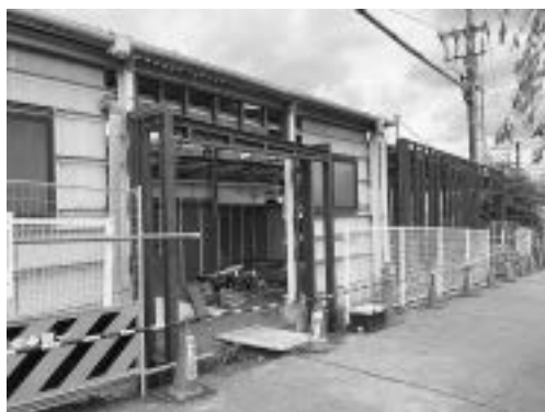
建設中の川角駅南口改札口
