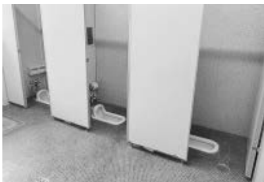
トイレ改修は、バリアフリーを視野に入れた改修を
