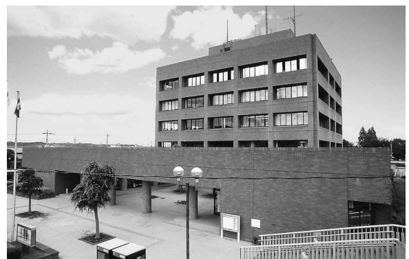
町民等は利用しない屋上に建つ2階～5階部分の庁舎の外壁
