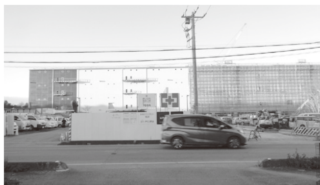
川角地区に開発工事の倉庫施設
