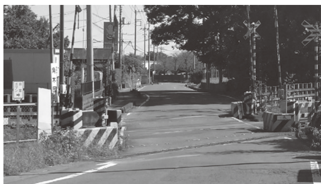
完成の目途が立たない日化団地踏切
