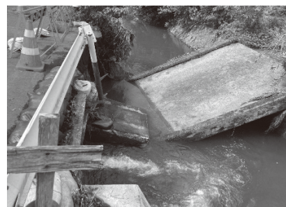
破損した葛川8号橋
