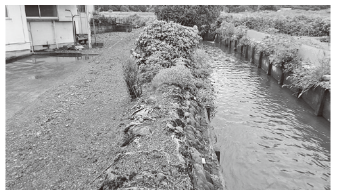
土嚢等の設置がなく、再び15世帯が床上・床下浸水した岡本団地
