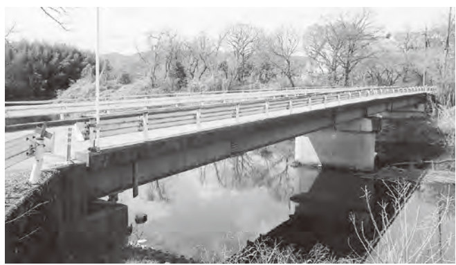
危険度の高い橋梁として、改修工事が始まる川角地内堂山下橋
