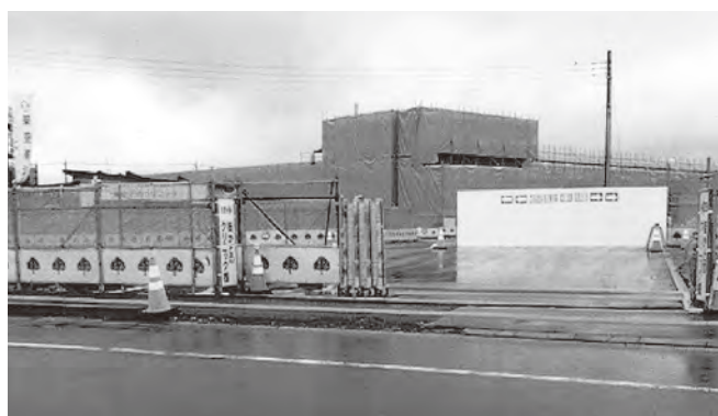
工事が進むイオン予定地
