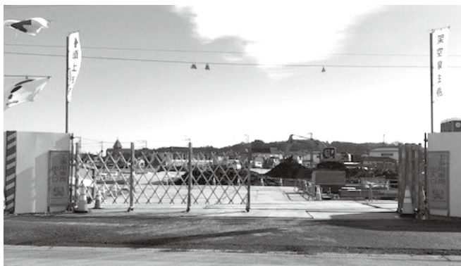
来年6月オープンに向け工事が進むイオンタウン
