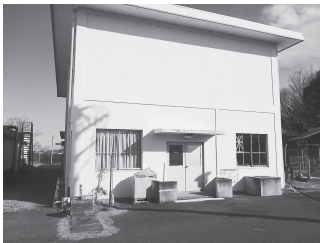
築55年経過し、老朽化が問題となっている苦林浄水場
