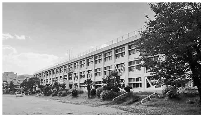
課題が残っている中進められる改修工事
