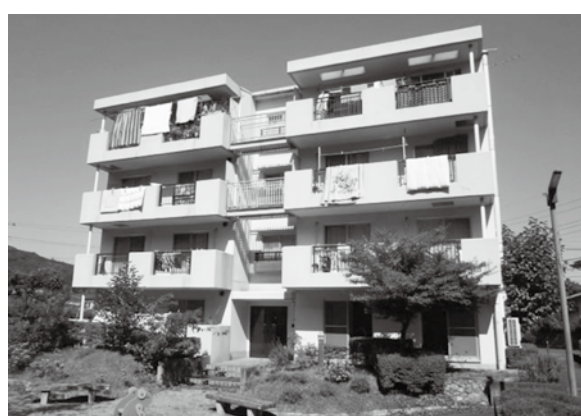
エレベーターのない町営住宅
