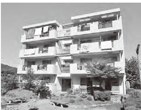
入居者の負担軽減が図られる町営住宅
