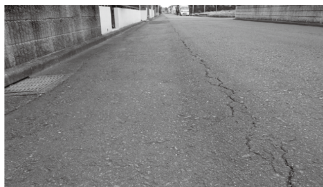
町民が危険な為、通報したが何年も補修されない町道(双葉団地内)
