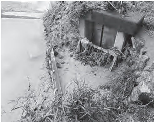
苦林・大類堰災害復旧工事 94万円 (川角地内)
