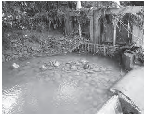
西戸堰災害復旧工事 115万円 (西戸地内)
