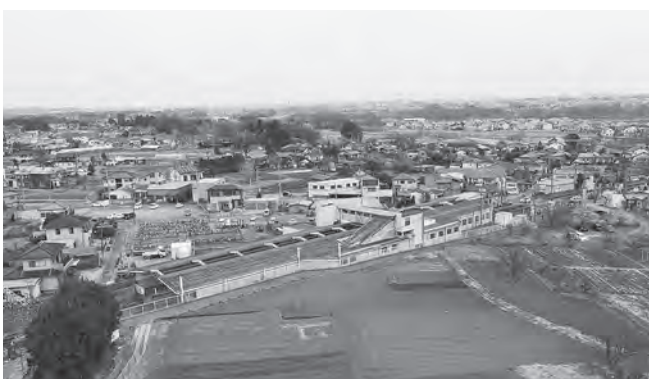
次年度からの着工を目指す川角駅周辺整備
