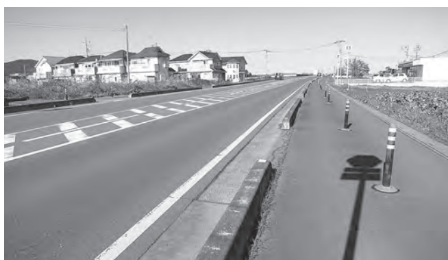
待ち望まれる幹線道路(写真は飯能寄居線)
