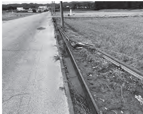
西戸耕地災害復旧工事 589万円 (西戸地内)
