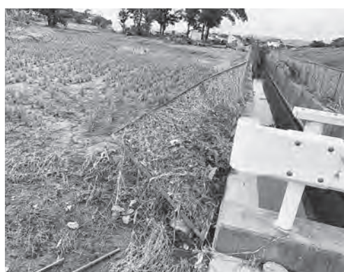
防護柵災害復旧工事 106万円 (苦林地内)
