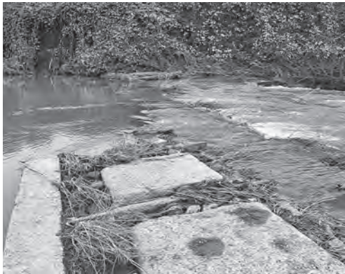
久保堰災害復旧工事 4,251万円 (岩井地内)
