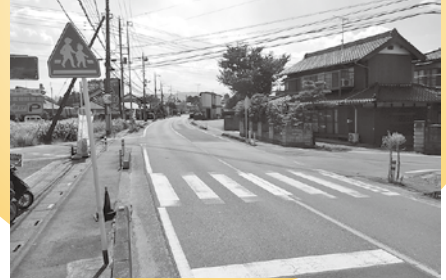
西大久保交差点改良工事
