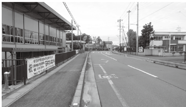
改修が待たれる町道7号線
