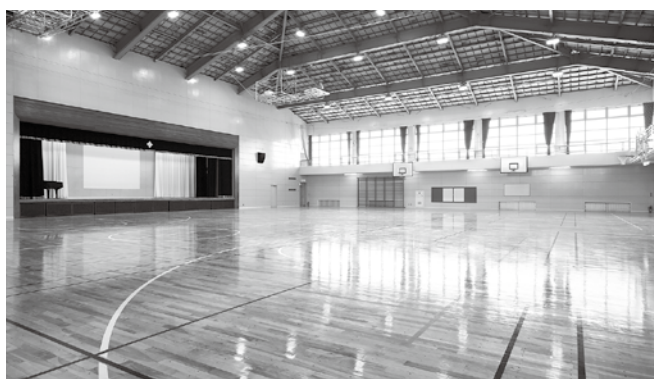
改修された毛呂山中学校体育館
