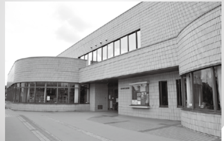
空調設備を修繕し、多くの利用を期待する図書館
