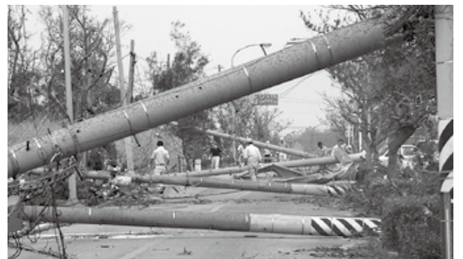
国土交通省が推進、無電柱化
