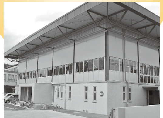
川中体育館大規模改造工事
