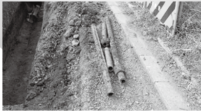
更新し、撤去した石綿管
