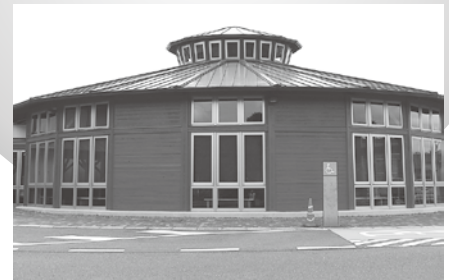
外壁がきれいになった東公民館
