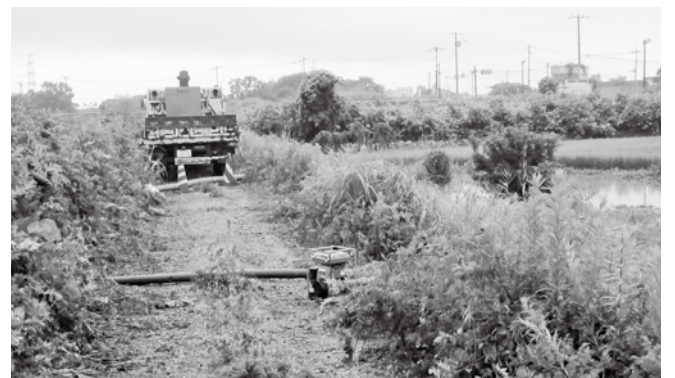
出勤している排水ポンプ積載のトラック
