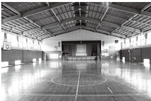
毛呂山小学校体育館
