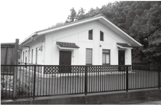
農業集落排水施設(葛貫地内)
