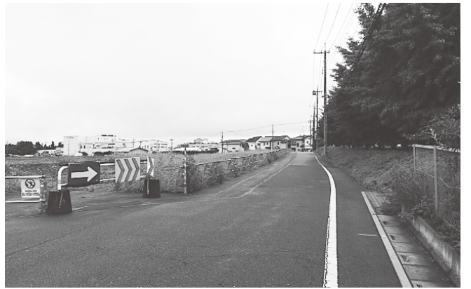
待たれる町道7号路線の拡幅工事
