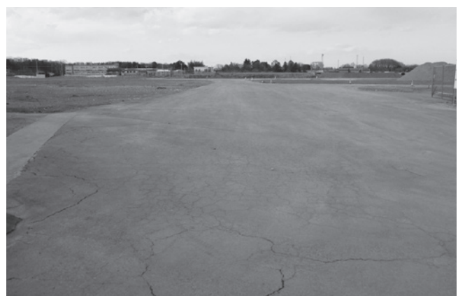
造成・整備された東部エリア(市場、川角地内)
