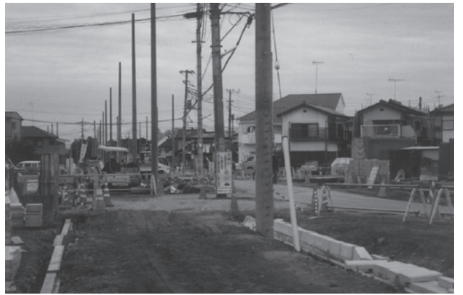
工事が進む都市計画道路(長瀬駅前野久保線)
