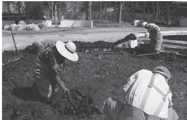
土の入れ替え作業は、人力では限界がある
