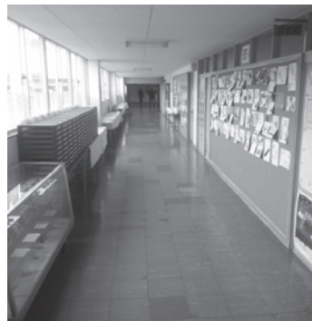
第1期木質化改造前の南棟
