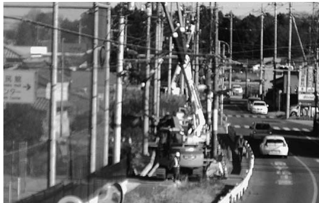
ようやく始まった川角交差点右折帯工事
