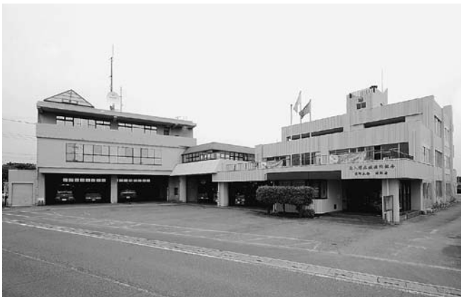
西入間広域消防組合庁舎
