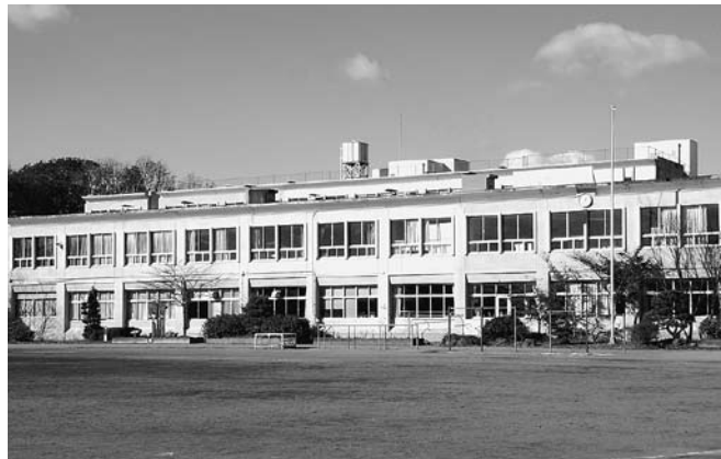
エアコンの設置は大規模改造事業で実施予定
