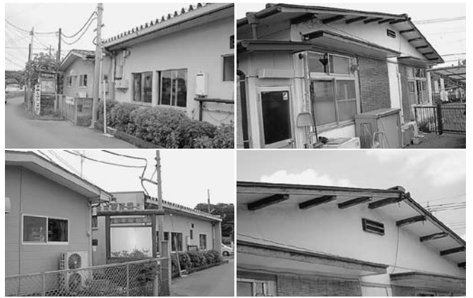
軽量鉄骨造の若草保育園〈左〉と川越市立A保育園〈右〉
