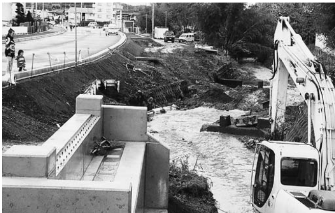
工事中の中橋より町田堰を臨む
