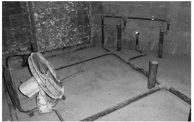
完成が待ち遠しい全面改修の小学校トイレ
