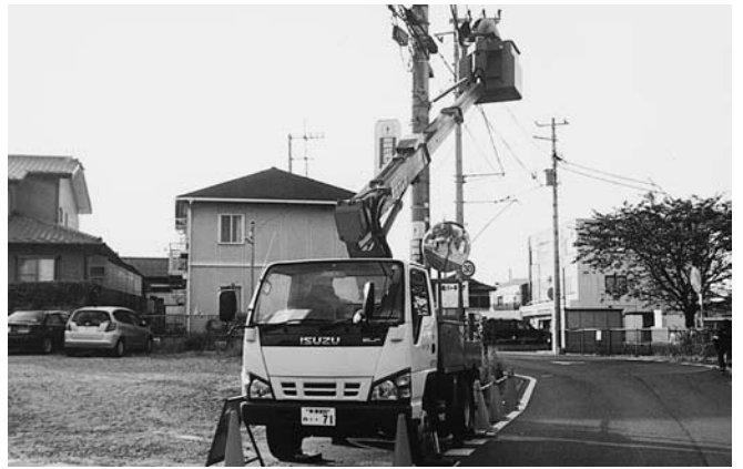
地デジ対策は早めに（進むCATV受信の架線工事）
