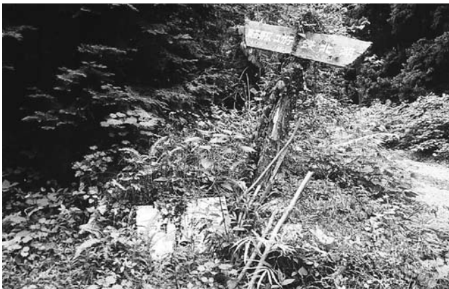
腐蝕が進んだまま放置されている道標
