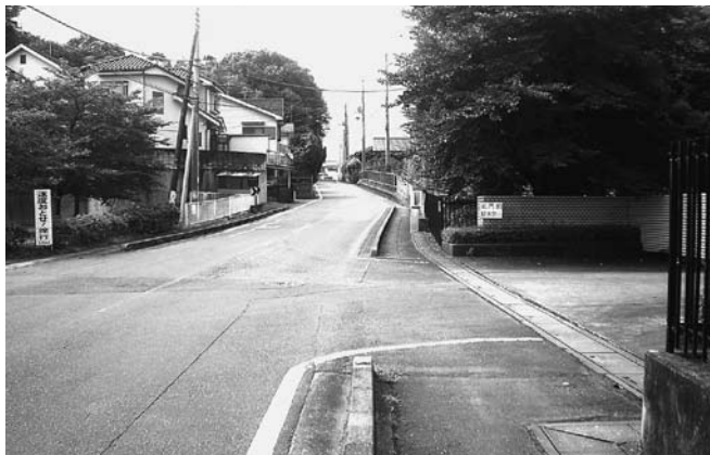
整備が放置されつづける箇所
